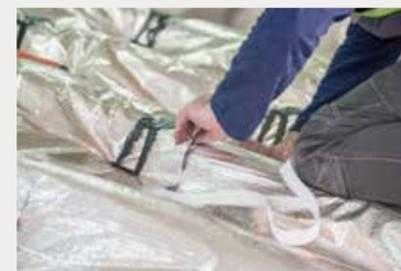
■ Aux jonctions des lés, les superposer et les fixer par agrafage ou à l'aide de l'accessoire ISOCLIP (cloueur), au choix. Veiller à la continuité de l'isolation.
