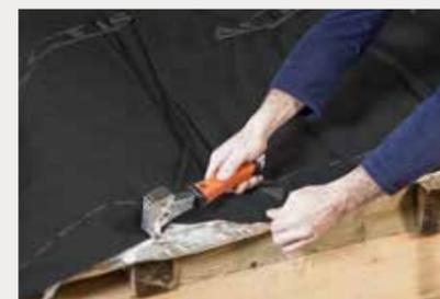
■ En périphérie de l'isolation, réaliser un retour d'isolant de 50 mm au minimum sur lui-même et veiller à la parfaite étanchéité périphérique.
